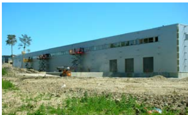
Opførelse af ny bygning til virksomheden Erik Bagger
